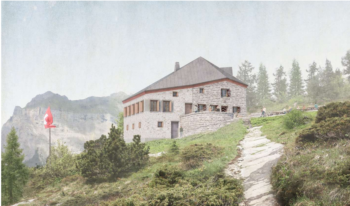
Abbildung 4: Doldenhornhütte nach Sanierung
